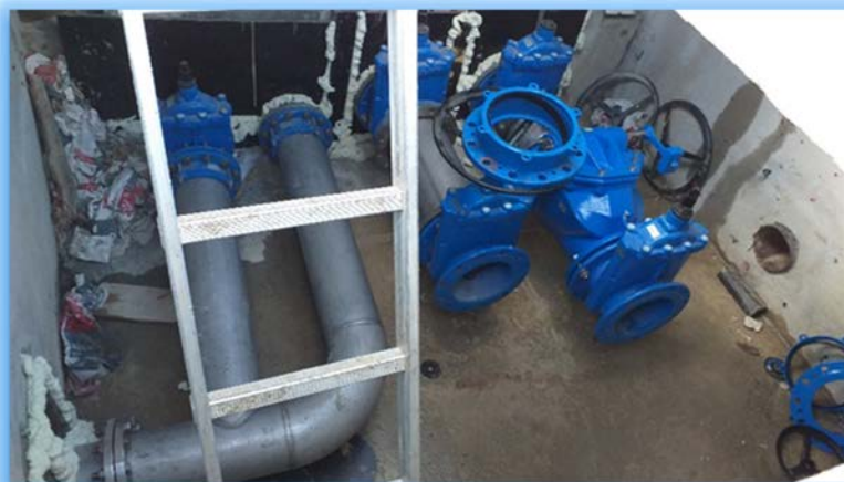
Réhabilitation hydraulique de la cuve n°1 de la Bataille - Chef Boutonne -
