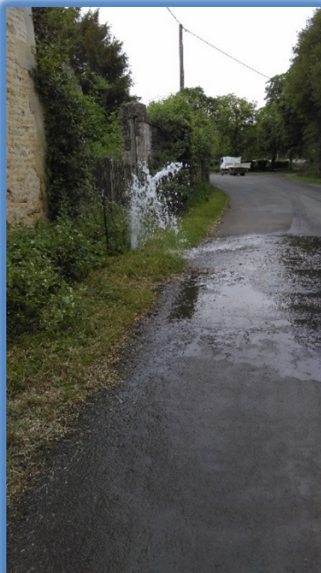
Réalisation d'une purge sur le réseau
